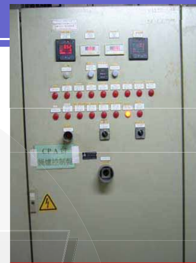
原有熱煤鍋爐控制盤
