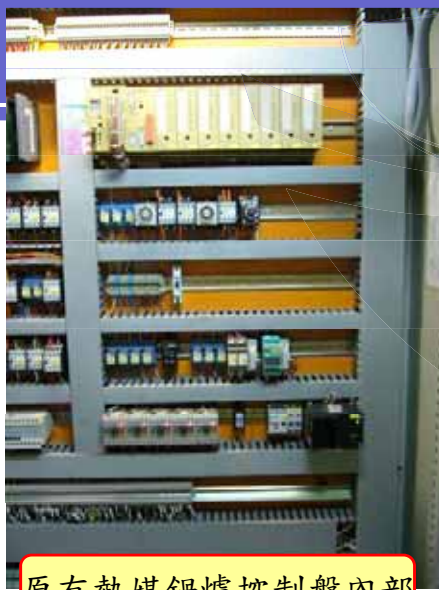
原有熱煤鍋爐控制盤內部
