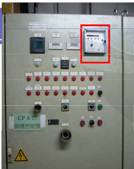
增加VMS微電腦燃燒控制器後的控制盤
