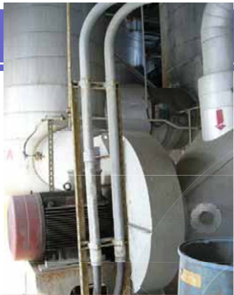
75KW 燃燒空氣送風機
